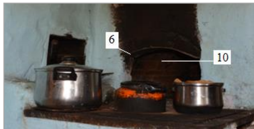
XIV. Piec : 1 – kapa, 2 – baba, 3 – polynisko, 4 – pöpielnik, 5 – badrura, 6 – piec chlybowy, 7 – zöpiecek, 8 – köciotek, 9 – blachy, 10 – czyluście.
