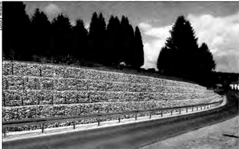
Zabezpieczone osuwisko w Manasterzu.
