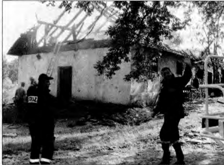
Gaszenie pożaru trwało kilka godzin. W płonącym budynku znajdowały się łatwopalne substancje.
