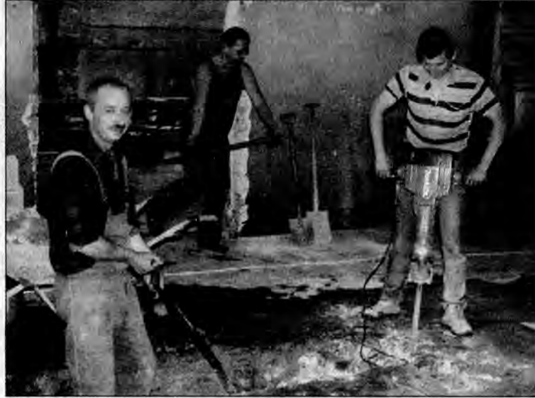
Prace przy modernizacji mają się zakończyć 15 września.
