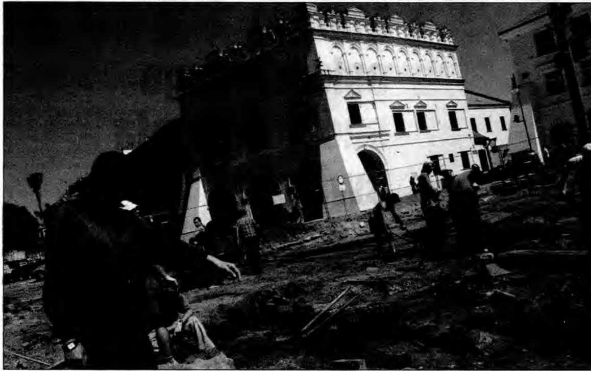
Prace archeologiczne na jarosławskim rynku mają odkryć rzut przyziemia świątyni farniej.
