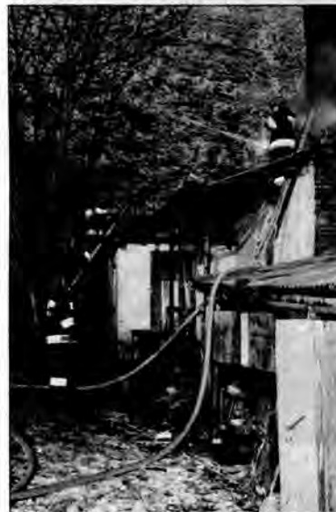
Po ugaszeniu pożaru strażacy musieli rozebrać część konstrukcji dachu.
