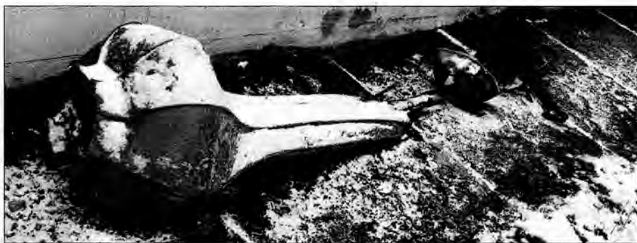
Prawie trzymetrowe zwińczenie wieży powalone przez wiatr.
