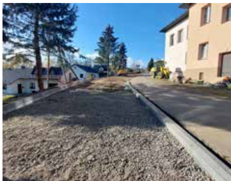
Nosówka - budowa parkingu przy Domu Kultury, pierwszy etap. Koszt prac: 85 456 zł
