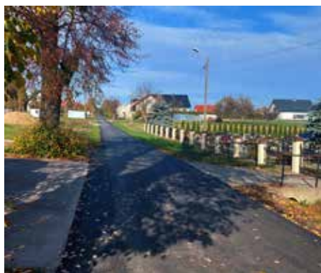
Lutoryż - nowa nawierzchnia na drodze 151200R (Kolonia - cmentarz). Koszt: 130 000 zł
