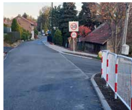
Boguchwała - budowa chodnika i remont nawierzchni przy ul. Grunwaldzkiej na długości 180 m. Koszt prac: 190 000 zł
