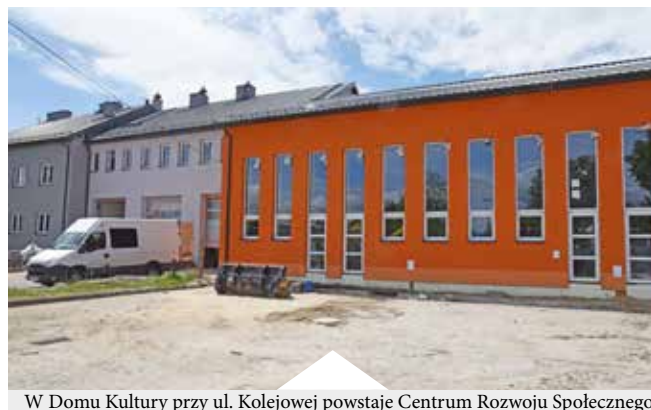
W Domu Kultury przy ul. Kolejowej powstaje Centrum Rozwoju Społecznego
