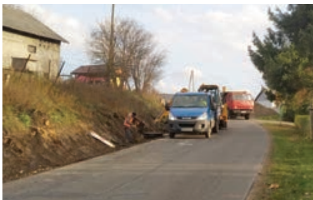
Prace na ulicy Potockiego w Łęczanach
