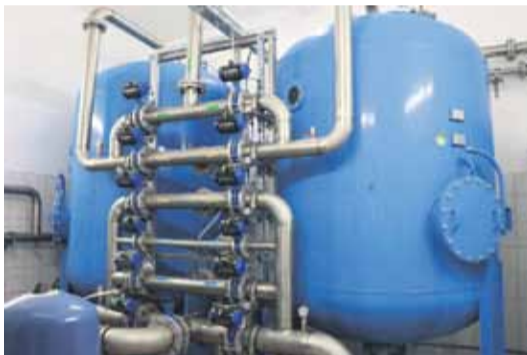
Dzięki funduszom pozyskanym z programu „Polski Ład” Gmina Łańcut mogła rozpocząć rozbudowę Stacji Uzdatniania Wody w Kraczkowej
