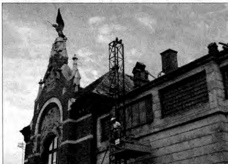
Miejski Ośrodek Kultury, tzw. Sokół ma wymieniany dach, nowa elewacja planowana jest na rok następny.
