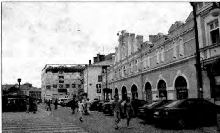
Od ulicy Grodzkiej hala targowa wygląda już pięknie, w tle remontowana kamienica Orsettich.
