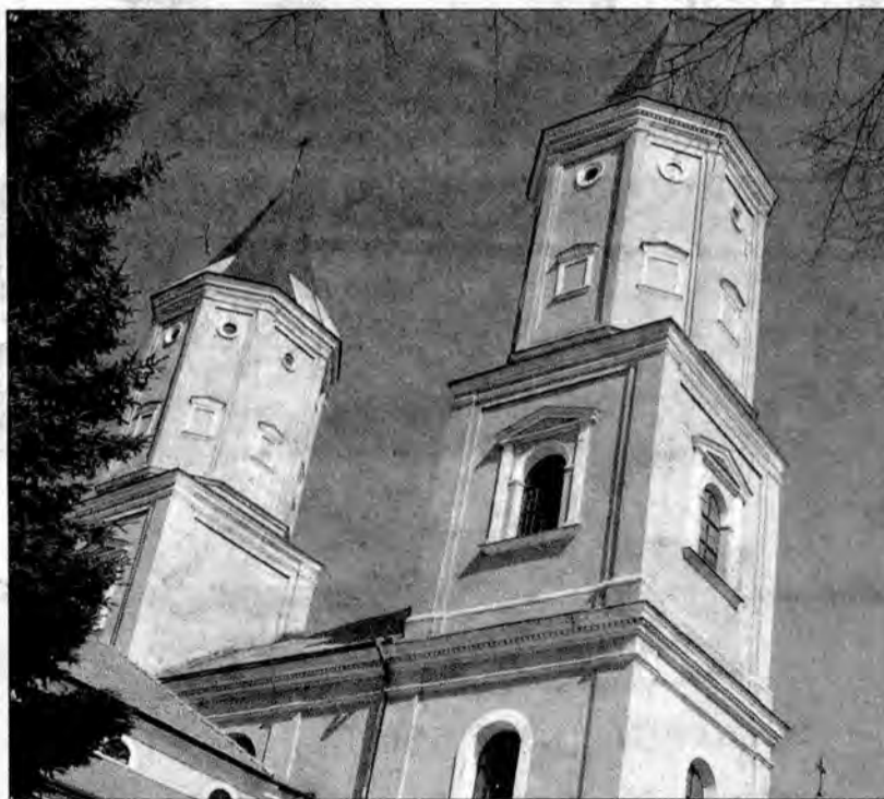
Prace zabezpieczające fundamenty mają uchronić klasztorną wieżę przed dalszym odchyleniem.
