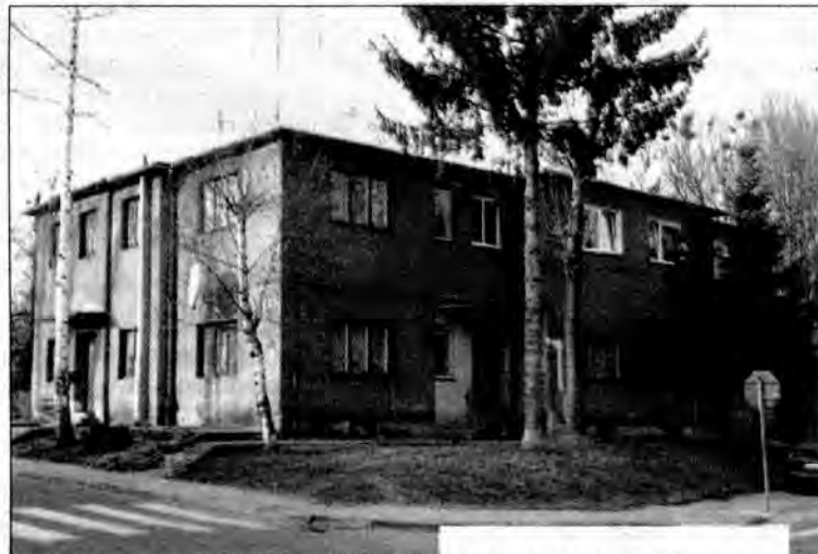
W budynku przy ul. ks. Ożoga 6 już w tym roku zacznie się remont.
