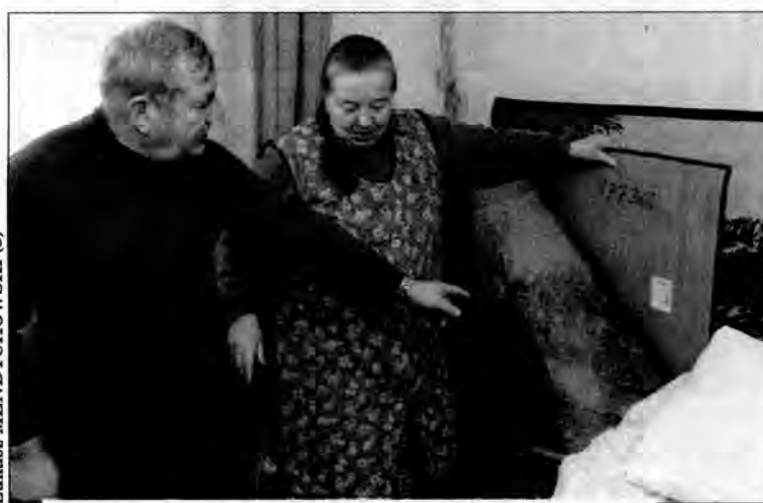
Mieszkańcy kolejowego bloku przy Mickiewicza 51 w Przemyślu są bezradni. Grzyb jak był na ścianach – tak jest, a kolej tłumaczy, że na ocieplenie budynku nie ma pieniędzy.
