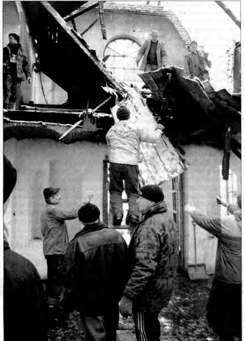
Mężczyźni demontują resztki popalonych krokwi i płyty blachy.
