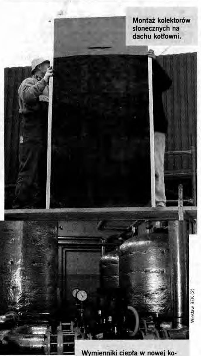
Wymienniki ciepła w nowej kotłowni na osiedlu Unii Lubelskiej.
