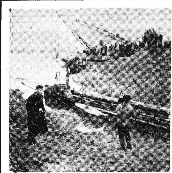
W dniu 28. XI. 61 r. druga nitka rurociągu naftowego biegnąca z ZSRR przez Polskę do NRD, spięta oba brzoży Odry. Na zdjęciu: Fragment układania rurociągu przez CAF—fot. Gonczarow Odre.
