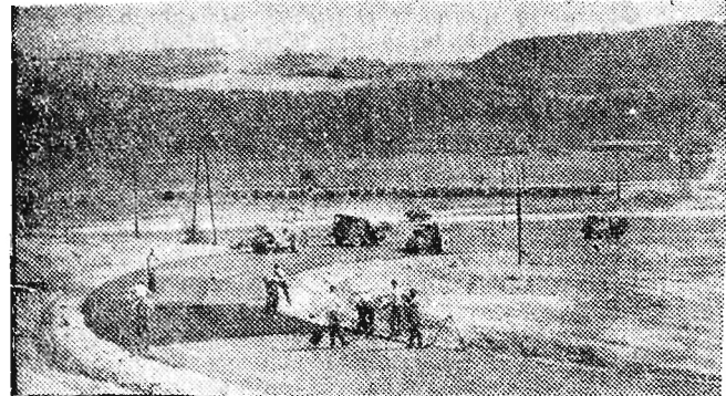
Na zdjęciu: Na placu budowy.
