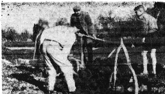
Przy budowie nowej drogi pracują wszyscy. Najstarsi i najmłodsi.
