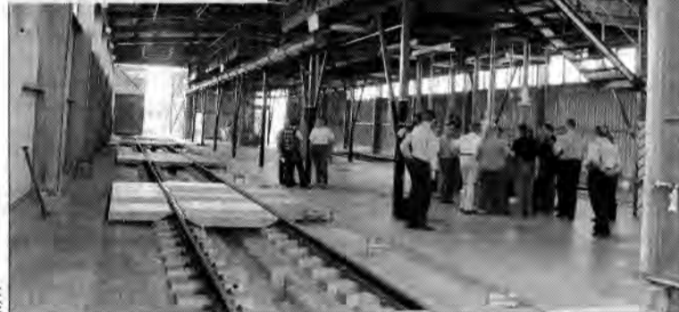
Przy odbudowie terminalu wykorzystane zostały najnowocześniejsze surowce i zabezpieczenia.
