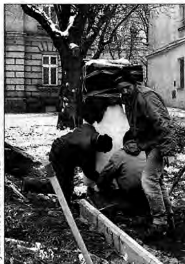
Prace przy cokole dla popiersia marszałka Piłsudskiego są już na ukończeniu.
