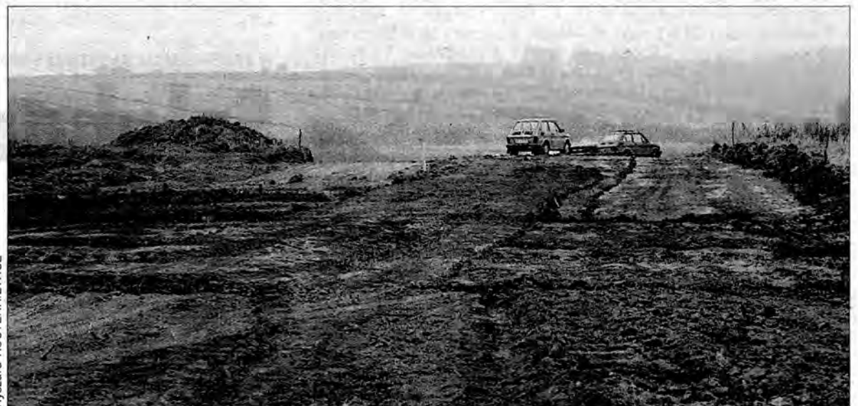
Ruszyła budowa składowiska odpadów komunalnych dla Przemyśla.
