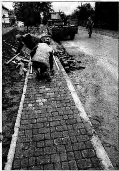
Budowa chodnika przed gimnazjum w Krzywczy.
