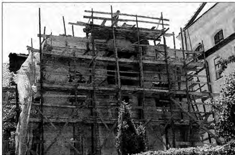
Na 10-metrowej dzwonnicy wciąż trwają prace budowlane.
