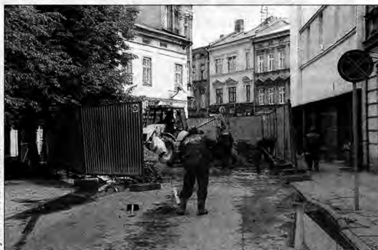
„Wykopki” wzdłuż ulicy Kazimierza Wielkiego w Przemyślu potrwać do końca wakacji.
