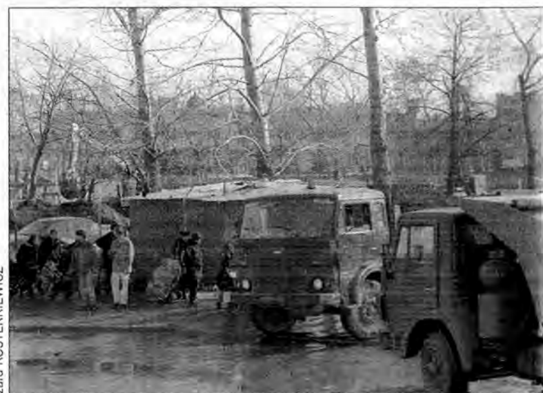
Błoto, jeżeli jest, powinno zostać na placu budowy.
