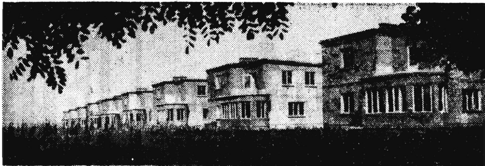
Dzięki inicjatywie i dużej pomocy ze strony dyrekcji Fabryki Porcelany w Boguchwałe — można już dziś obejrzeć osiedle nowoczesnych domków wybudowanych przez pracowników tego zakładu.
