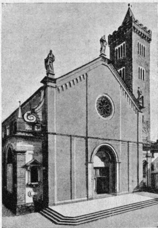
Fig. 16. — Sarzana: FACCIATA DELLA CATTEDRALE.
