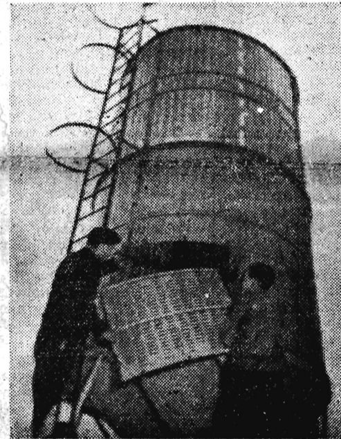
Na zdjęciu: Demontaż na terenie fabryki gotowego silosu rurowego, który następnie zostanie zmontowany w spółdzielni produkcyjnej. Fot — CAF
