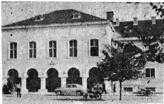
Siedziba Prezydium PRN. Dzięki temu, że w roku bieżącym budynek ten otrzymał elewację, znacznie zyskał na estetycznym wyglądzie. Fot. (m)
