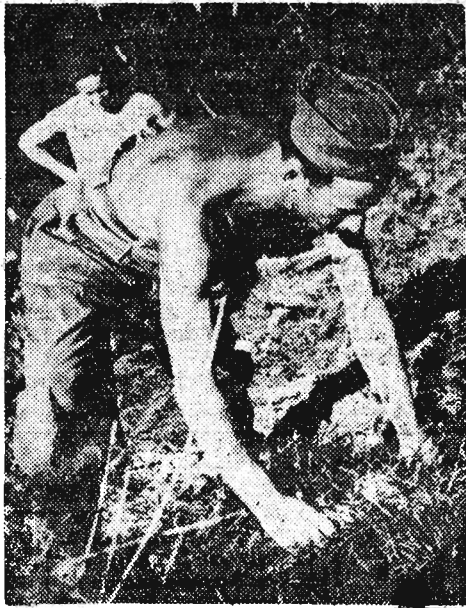
Brugadzista Stefan Hodyr przy pracy.
