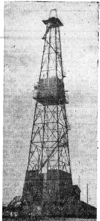
Otwory gazowe w Lubaczowie dostarczają tak potrzebnego dla naszej gospodarki gazu ziemnego. Oto jeden z szybów gazowych.
