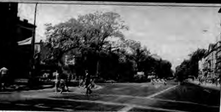
Dobiegają końca prace modernizacyjne przy skrzyżowaniu ul. Jana Pawła II, Kraszewskiego, Słowackiego, Grunwaldzkiej w Jarosławiu. Już wkrótce zostanie usprawniona organizacja ruchu na tym neuralgicznym skrzyżowaniu.
