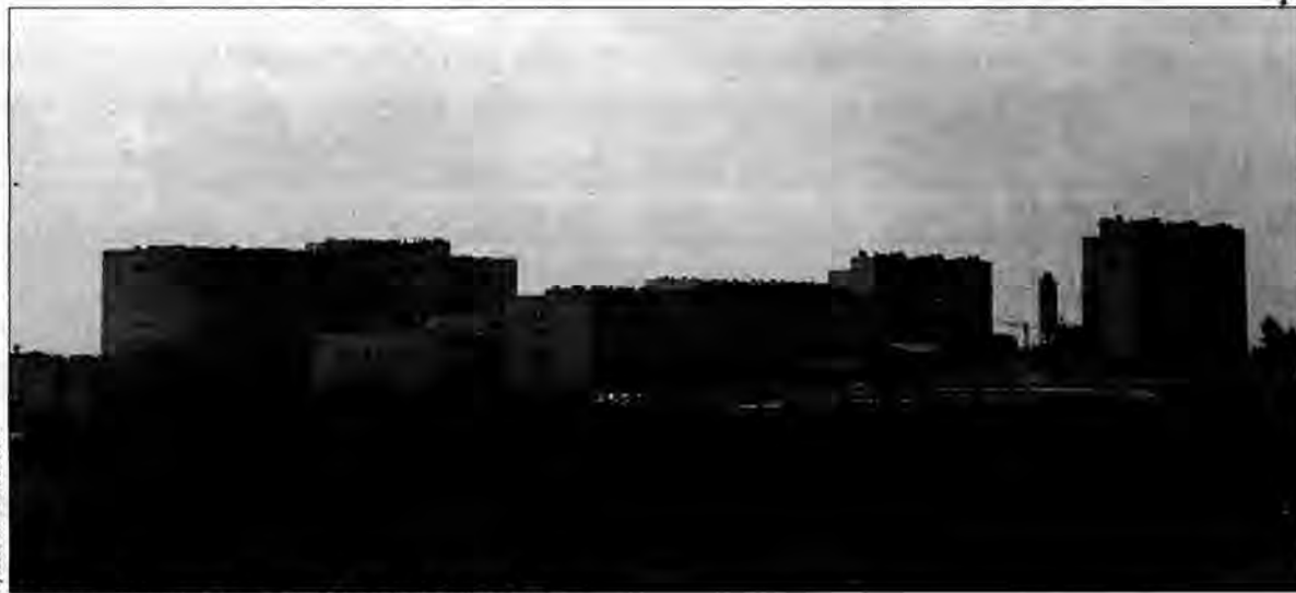
Widok ogólny na przemyski szpital w budowie.
