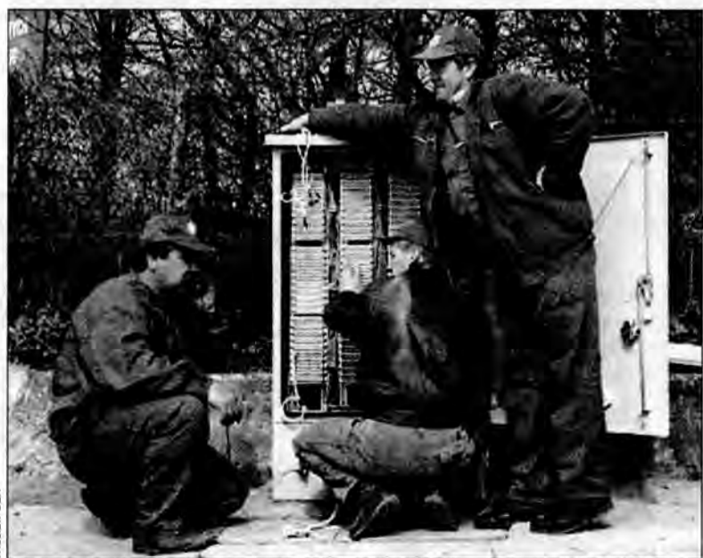
Sprawną akcją służb telekomunikacyjnych zapewniono szybkie podłączenie głuchych telefonów.
