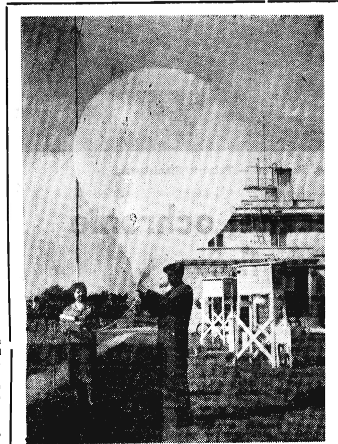
” Zakład Aerologii w Legionowie k/Warszawy jest jedną z licznych placówek Państwowego Instytutu Hydro-Meteorologicznego, rozsiągniętych na terenie całego kraju. Głównym jego zadaniem jest prowadzenie badań atmosfery. Wykonuje się tu pomiary prędkości wiatru i jego kierunków, ciśnienia atmosferycznego oraz temperatury i wilgotności powietrza.
