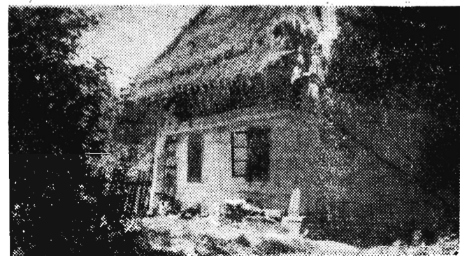
Markowa pow. Łańcut. Dom o konstrukcji przysłupowej.
