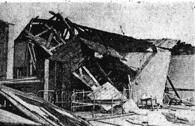
Barak zamieszkiwany przez robotników ZBM legł dostojnie w gruzach. Pozostało rumowisko desek, cegieł, potłuczonego szkła.
