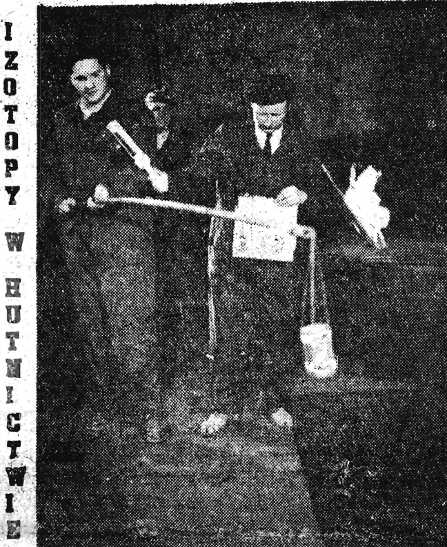
Po raz pierwszy w historii polskiego hutnictwa zastosowano izotopy promieniotwórcze. W hucie im. Lenina umieszczono izotopy talu, srebra i kobaltu w blokach węglowych, którymi wyposażone są trzony wielkich pieców. Dzięki izotopom będzie można kontrolować zużycie trzonu.
