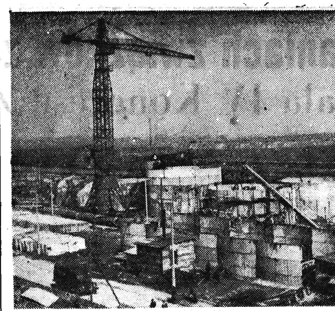
Obok kombinatu im. Lenina buduje się wielką cementownię, która będzie produkować ponad 700.000 ton cementu rocznie z żużla wielkopiecowego. W czasie budowy stosuje się w dużej mierze prefabrykaty produkowane bezpośrednio na miejscu.
