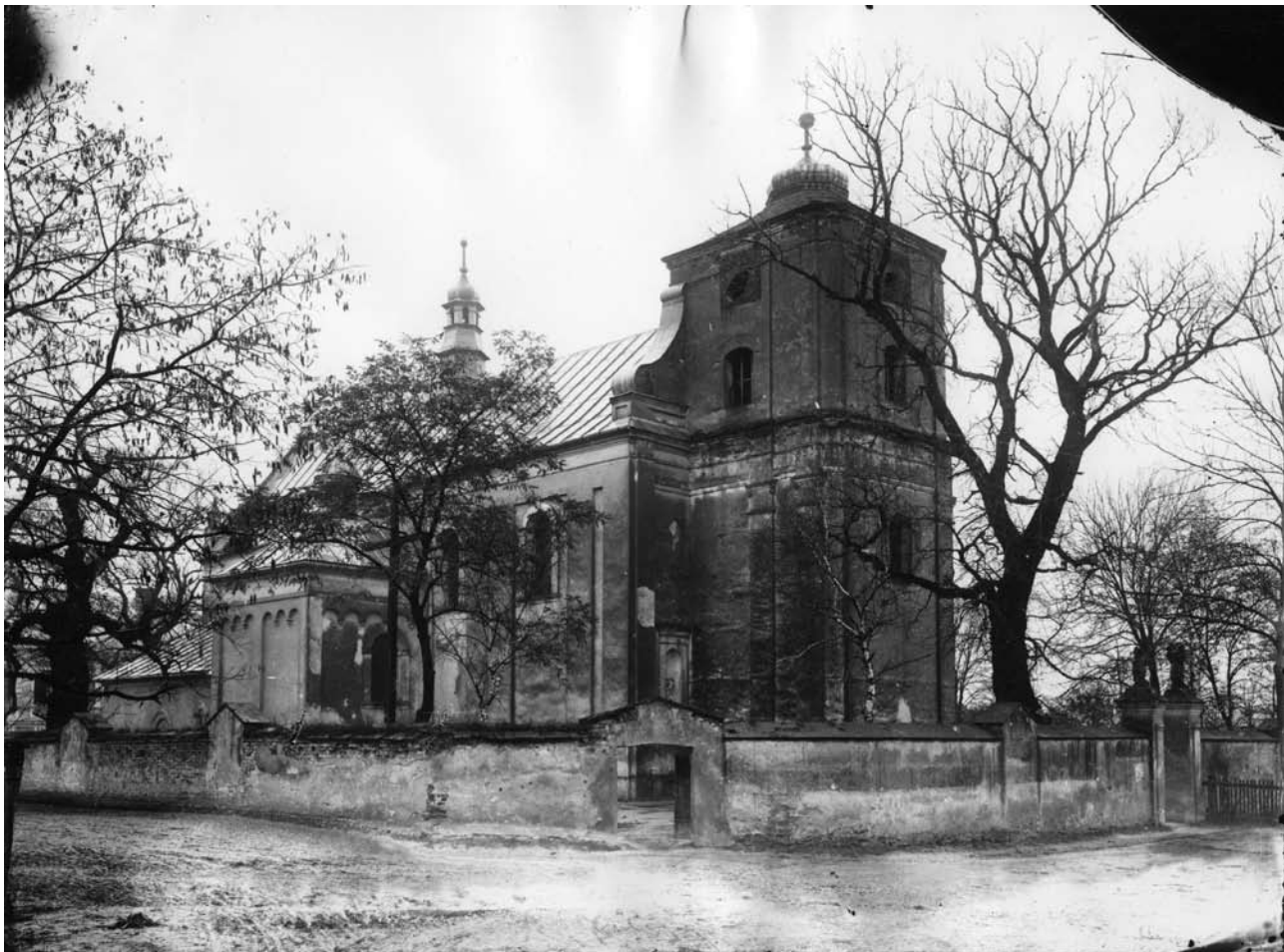
Widok kościoła z okresu przedwojennego (foto arch. J. Witka)
