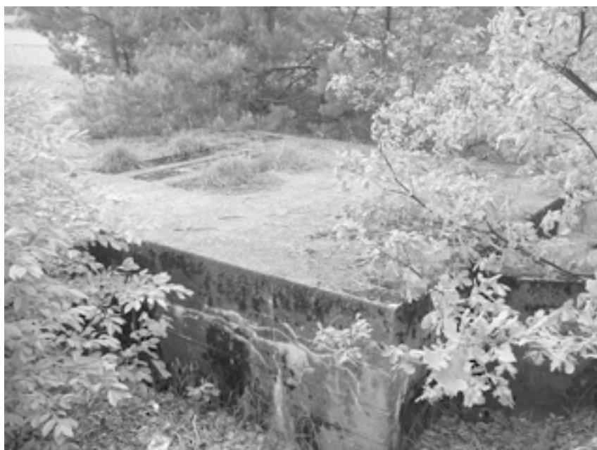
Fundament wyrzutni rakiet V1 (fot. autor)
