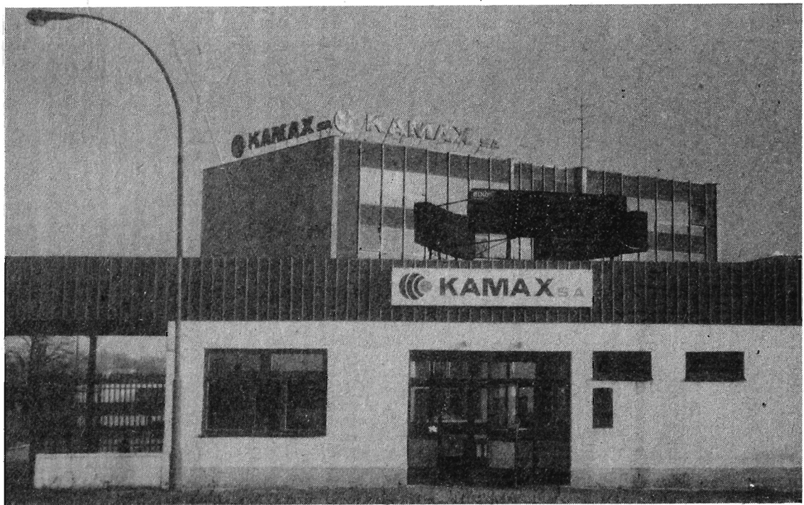
Kańczucki „Kamax” jest m.in. producentem urządzeń do odsiarczania spalin kotłowych.
