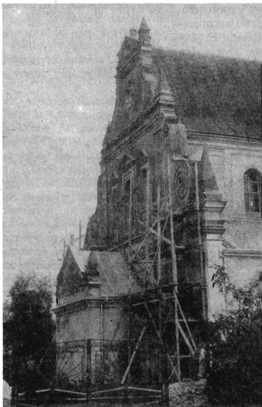
Fasada kościoła w Rudkach (stan z października 1989 r.).
