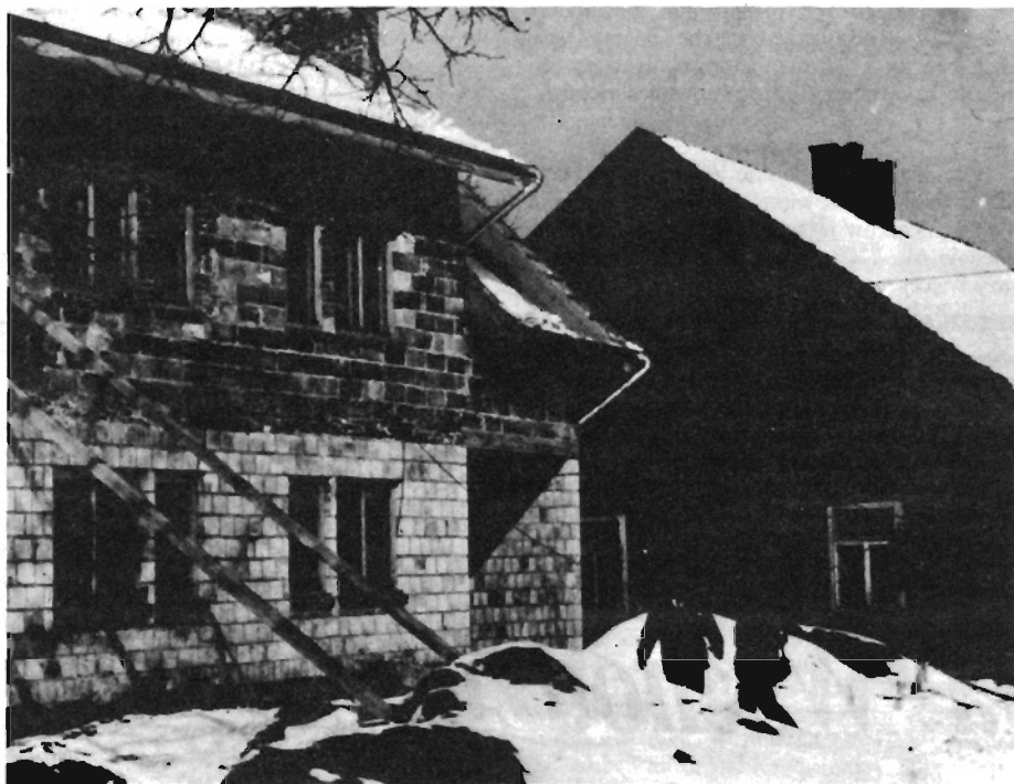
Makowiska. Świetlica w budowie.
