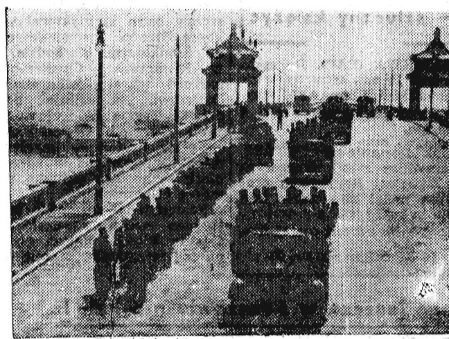
W końcu ubiegłego miesiąca oddano do użytku nowy most na rzece Jang-tse, największy most na wschodniej półkuli. Przez most przebiegają podwodne tor kolejowe oraz autostrada dla ruchu kołowego. Nowy most umożliwił bezpośrednią komunikację między Pekinem i Kantonem. Długość mostu wynosi 1700 metrów.
