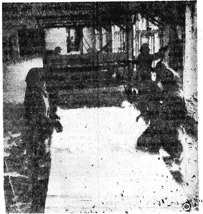
Ten biały „puch” to skłębiona przędza szklana. Za chwilę specjalna maszyna „uszyje” z niej doskonałe maty izolacyjne. Robotnice pracują w rękawiczkach i maseczkach — ze szkłem nie ma żartów. FOTO: EL-KA
