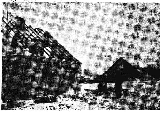
Na zdjęciu: Domek mieszkalny buduje spółdzielca Jan Nagórski. CAF - fot. Ukłejewski
