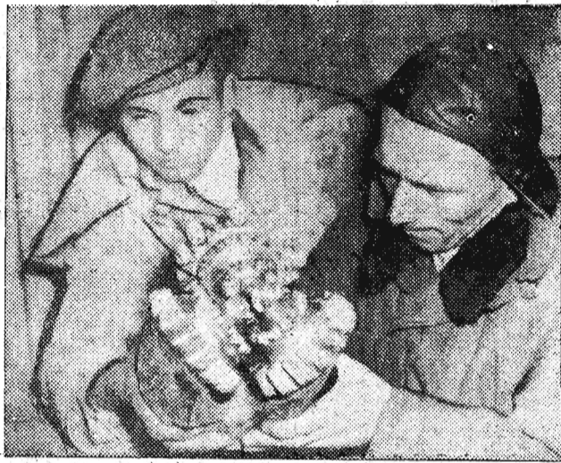
„Luz płonowy” łożysk „gryzera” wprowadził nieznaczny mimo to zapuścić do otworu po raz drugi nie można — dolatują nas słowa. Cóż to za terminy? To kierownik kopalni Czesław Dusza sprawdza z wiertaczem świder „gryzera” po odwierceniu pewnej ilości metrów.
