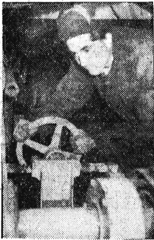
Motorniczy Kazimierz Bugala przy urządzeniach w szybie naftowym jednej z kopalni Jasieńskiego Kopalnictwa. Urządzenie jakim pracują wiertacze tego szybu jest skonstruowane w Fabryce Maszyn i Sprzętu Wiertniczego w Glińsku Mariampolskim. Załoga wiertnicza wierci nim bezawaryjnie już piąty otwór. Wszystkie poprzednie otwory zostały przekazane do eksploatacji i mówiąc popularnym językiem naftowców — dają ropę.
