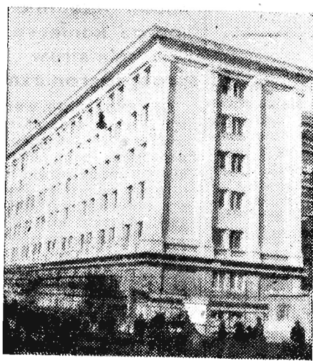
Tak wygląda z drugiej strony tj. przy skrzyżowaniu ulic Grunwaldzkiej i 1 Maja gmach WRN. Budynek ten stanowi ozdobę ruchliwej arterii naszego miasta. Fot. Popijakowski
