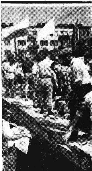
W dniu 8. VIII. 1955 r. członkowie delegacji zagranicznych wzięli udział w budowie szkoły przy ulicy Narbutta. Na zdjęciu: Delegaci przy pracy. CAF — fot. Pińkowski
