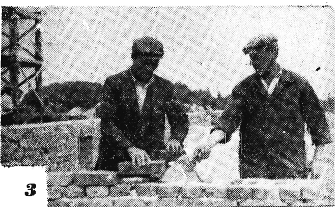
Na zdjęciu 2: Murarz Władysław Grodecki, który podjął indywidualne zobowiązanie wykonywania wszystkich ścianek grubości 1/4 cegły z płyt siporexu, przez co oszczędził zaprawę murarską i 15.000 sztuk cegły dziurawki. W. Grodecki wykonuje przeciętnie 190 proc. normy.
